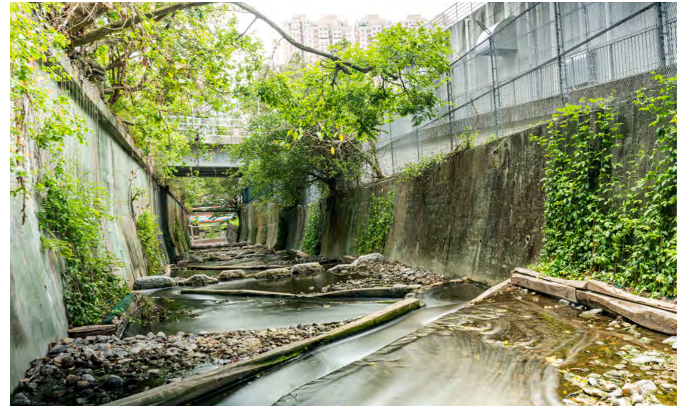
佐敦谷明渠活化工程
